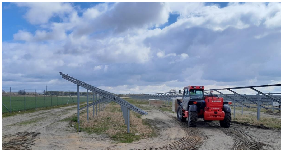
Rysunek 18 Przykładowy sprzęt budowlany na placu budowy (źródło: zdjęcie własne)
