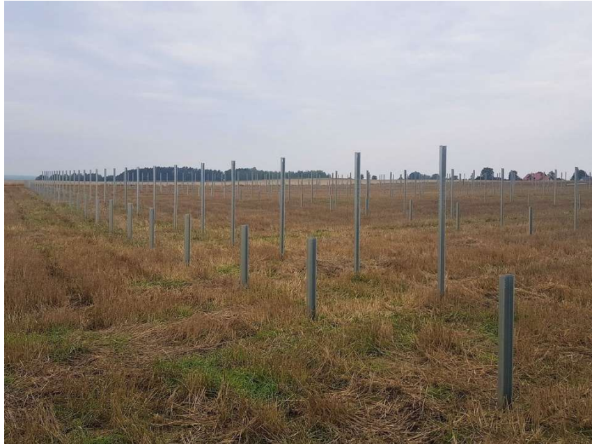
Fot. 14. Profile metalowe: podstawowy element konstrukcji ( https://www.energy5.pl/ ).
