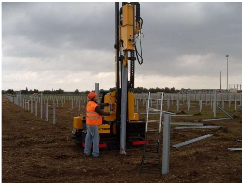
Fot. 15. Montaż profili za pomocą kafara ( http://www.liftonpolska.pl/ ).
