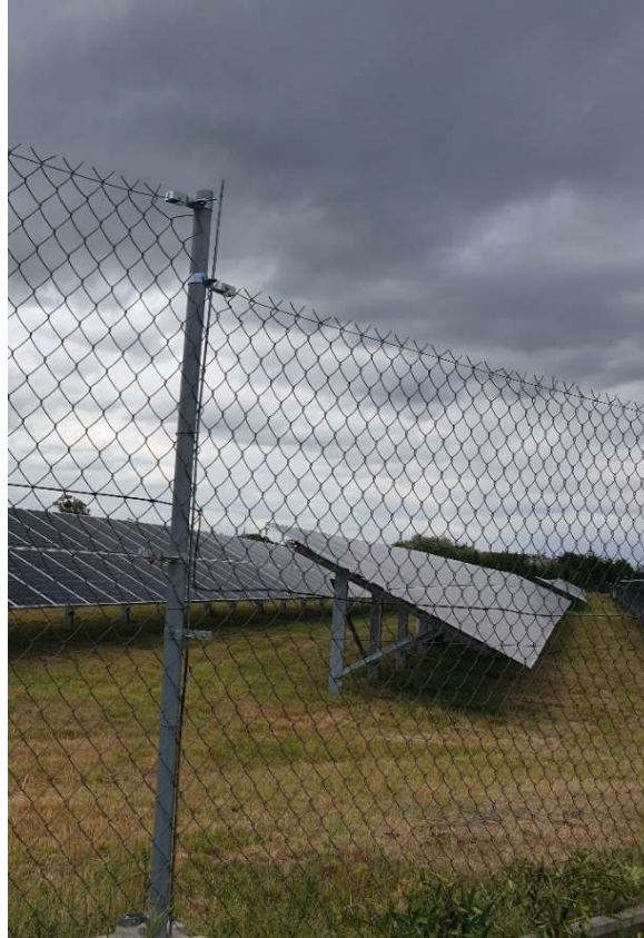
Fot. 13. Sposób montażu paneli fotowoltaicznych na stelażach wbijanych bezpośrednio do gruntu
