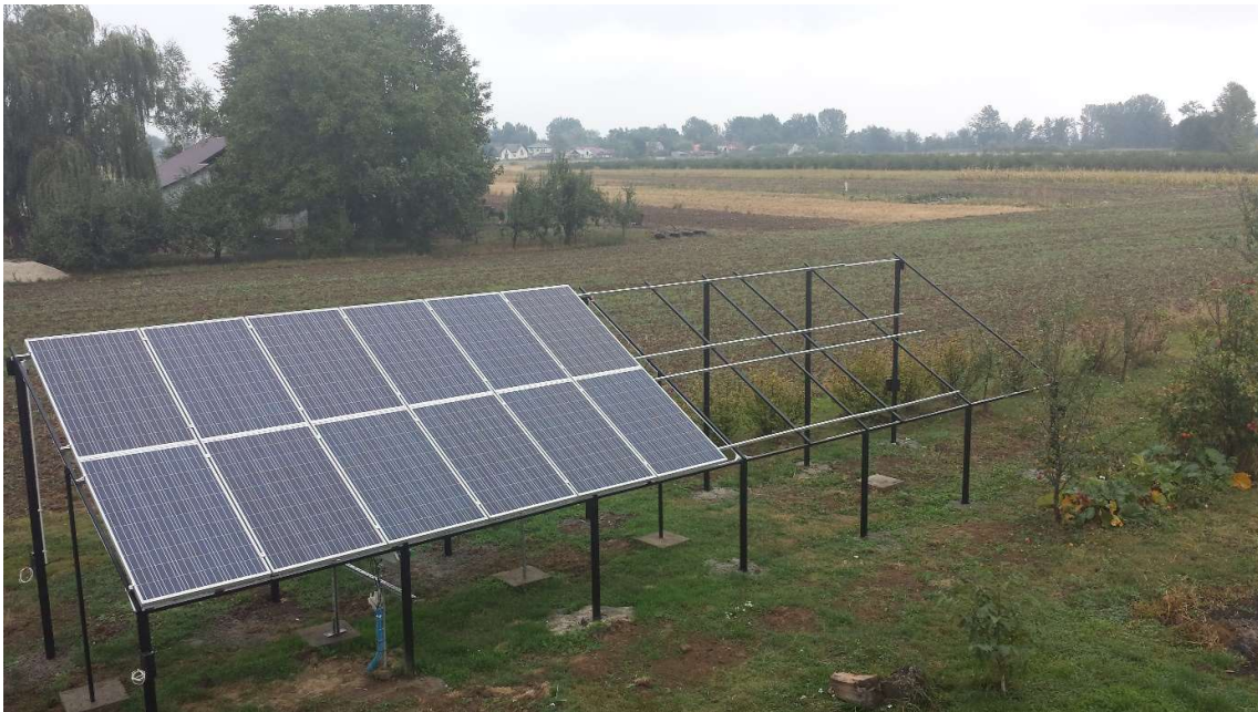
Fot. 1. Konstrukcja stołu z panelami fotowoltaicznymi (www.elektroda.pl)
