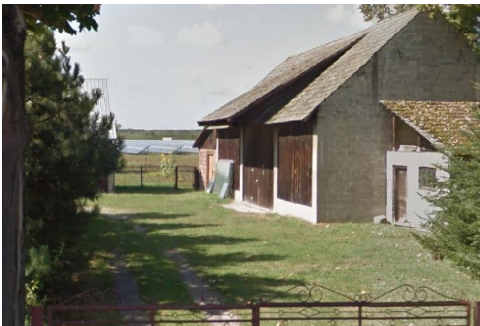
Fotografia 13 Widok w stronę przykładowej instalacji z odległości około 140 metrów
