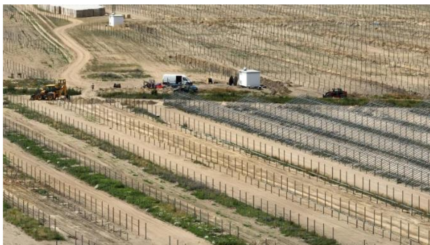
Fotografia 2 Budowa elektrowni fotowoltaicznej
