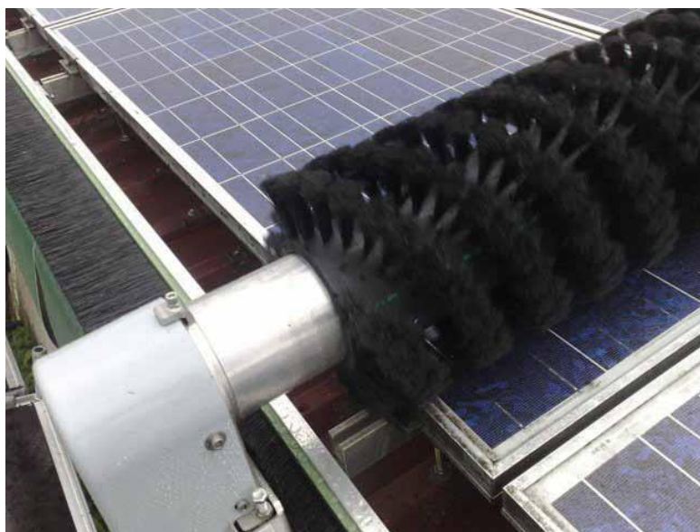
Fotografia 6 Bezwodna technologia czyszczenia paneli fotowoltaicznych
