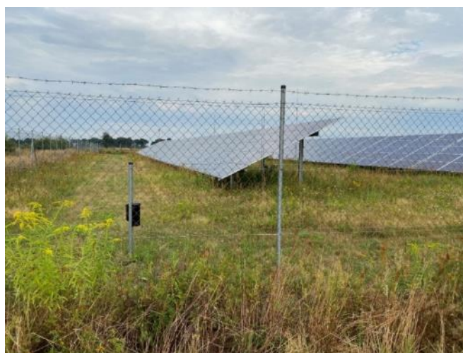
Fotografia 15 Roślinność na terenie istniejącej PV
