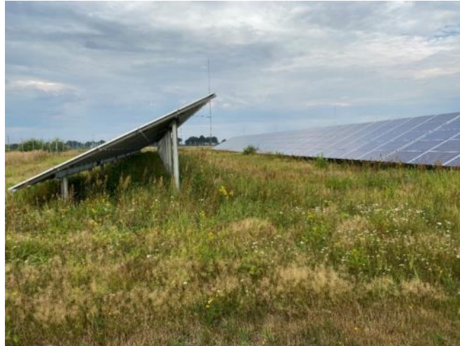
Fotografia 16 Roślinność na terenie istniejącej PV
