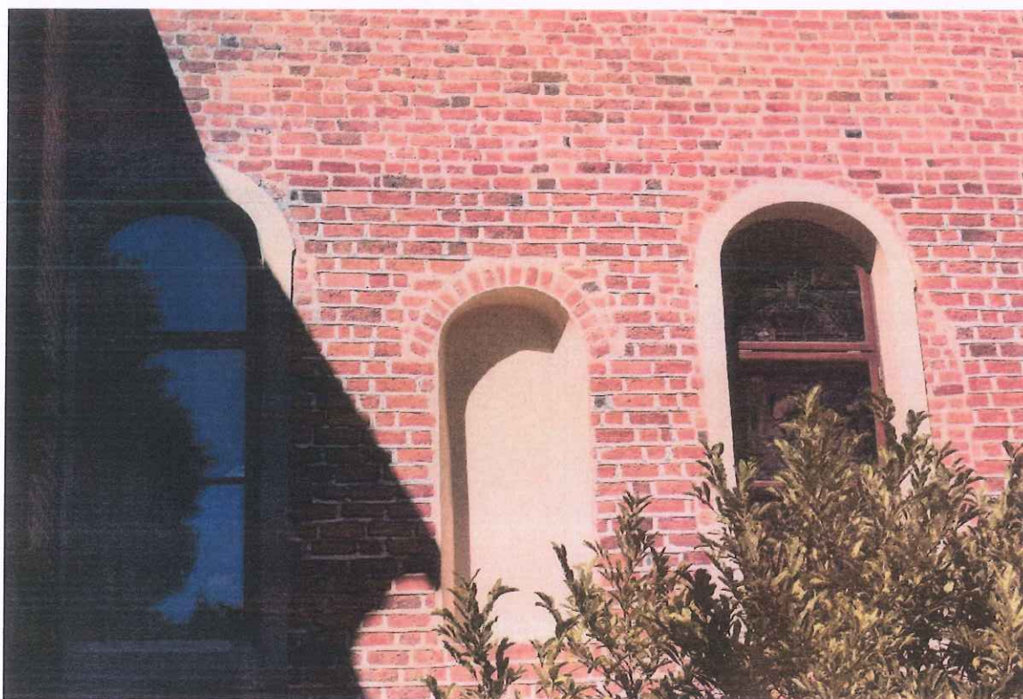
Fot. 2. Przeszklenia ochronne w drewnianych ramach od strony zewnętrznej.
