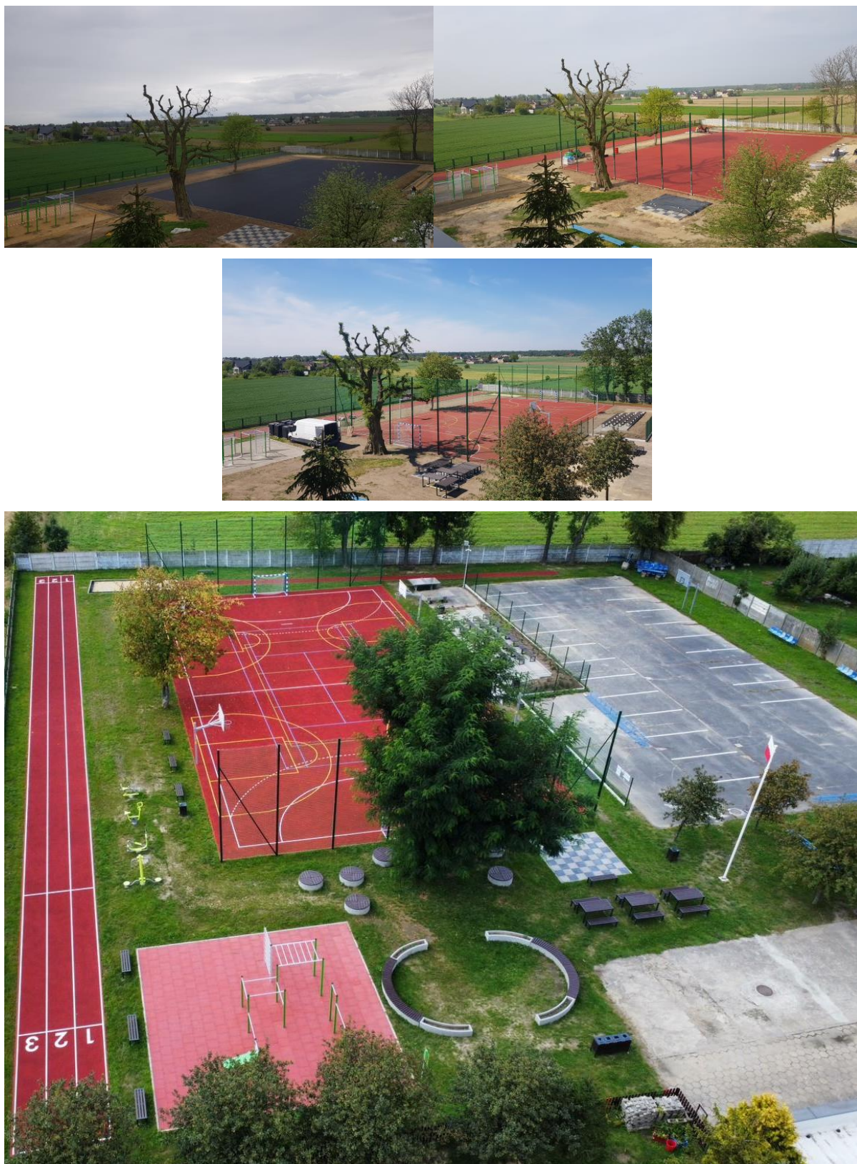
Zdjęcia z budowy boiska przy Szkole Podstawowej w Lamkach
