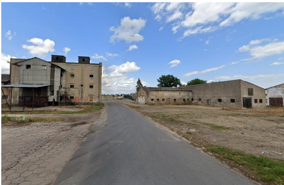
Zdjęcie 17. Zabytkowe budynki spichlerza i stajni w centrum wsi Borowiec
