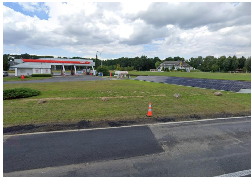
Zdjęcie 16. Zabudowa usługowa przy drodze krajowej nr 11 w Górznie
